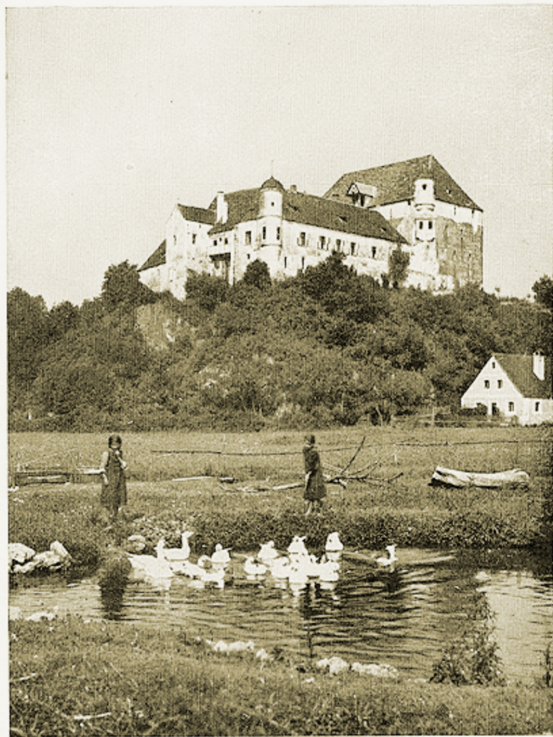
Abb. 1. Burg Heimhof von Südosten
