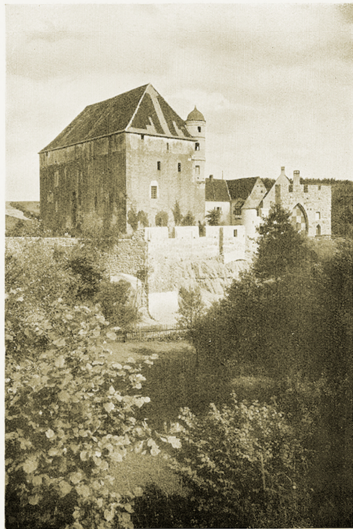
Abb. 3. Burg Heimhof von Nordwesten
