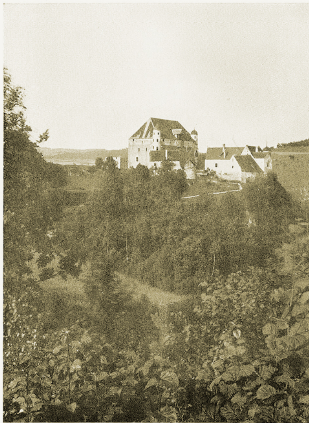
Abb. 2. Burg Heimhof von Südwesten
